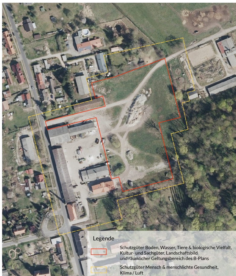
Abb. 1 Untersuchungsräume (Quelle: geoportal Brandenburg)
