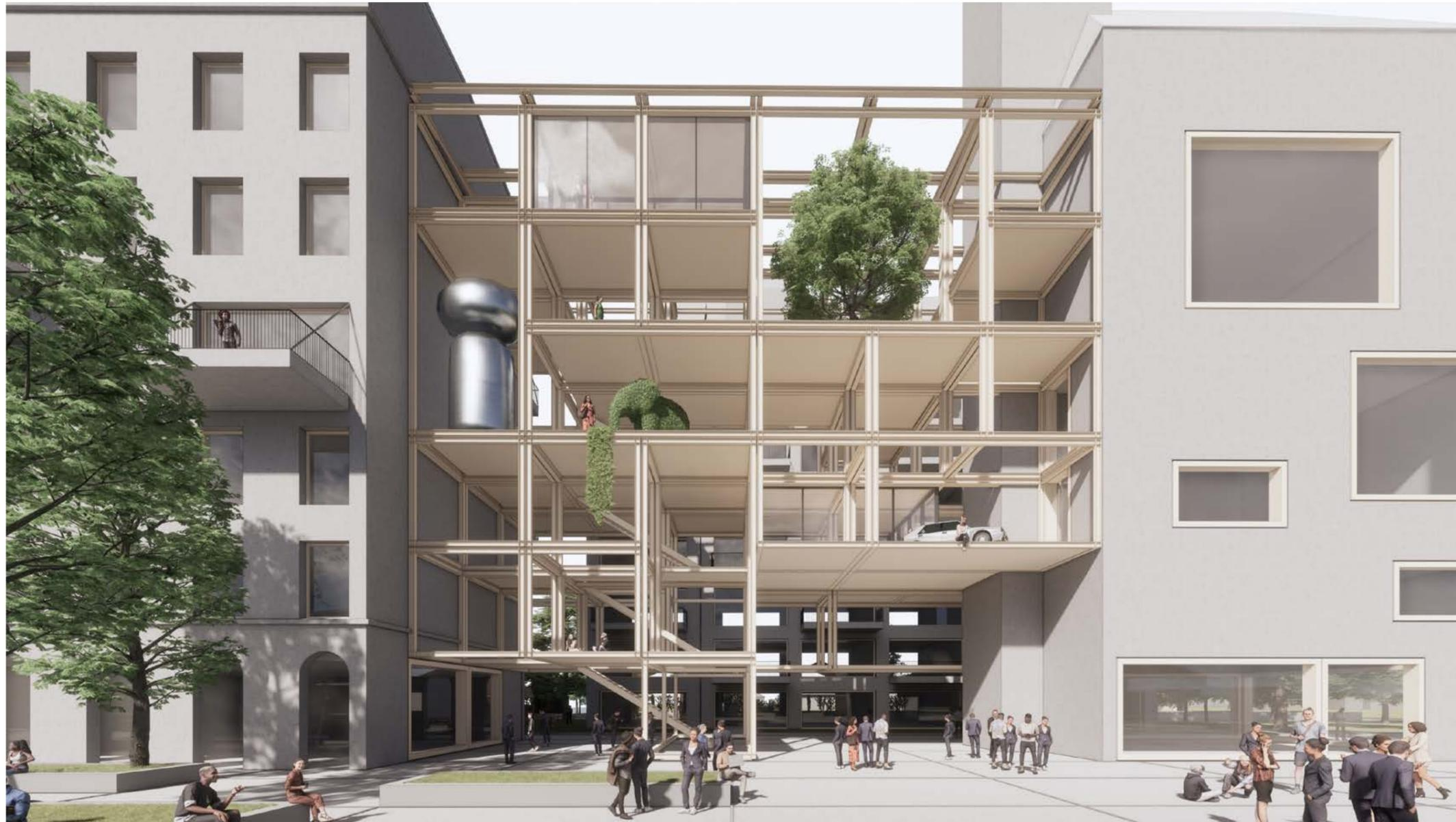
Das "Regal" ersetzt einen Gebäudeteil des Ensembles, der nicht mehr existent ist. Der Stahl der Struktur wurde unter Anderem zur Ertüchtigung der erhaltenen Häuser eingesetzt.'
