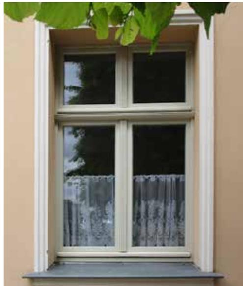
Mindestens 12 cm bzw. 24 cm von der Fassadenvorderkante in die Laibung zurückgesetzte Fenster in einheitlicher Materialität (Holz)
