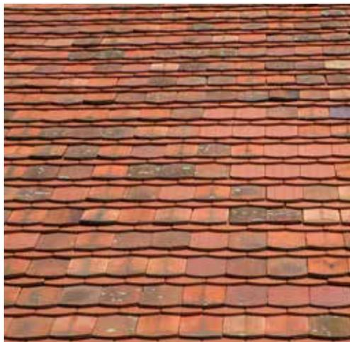
Dachdeckung in Tonziegeln mit Biberschwanz in Doppeldeckung
