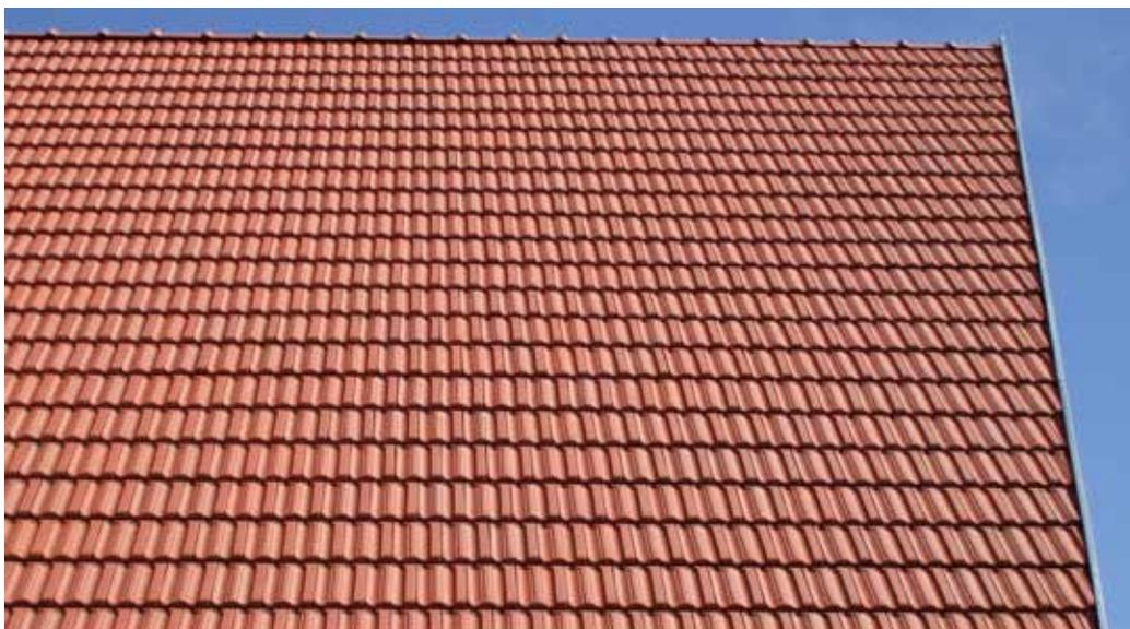
Dachdeckung in Tonziegeln in Doppelmuldenfalzziegel
