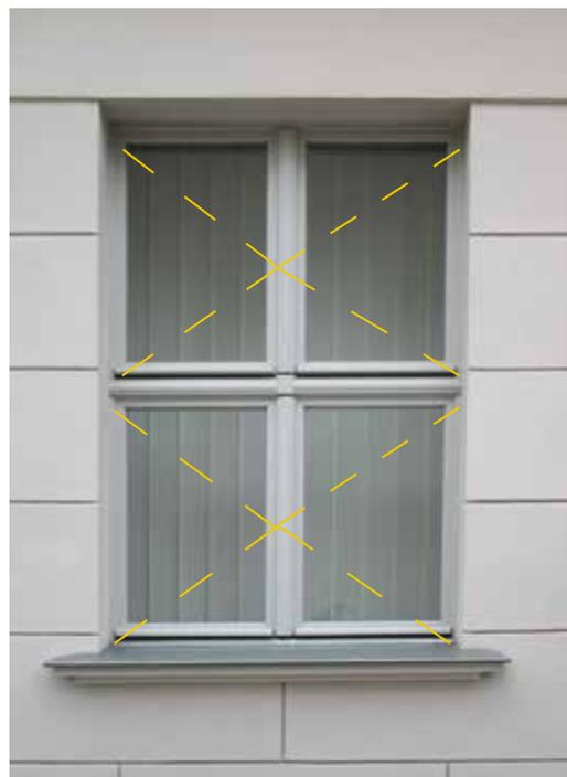
*Pfostens oder Stulps 14 cm betragen. Quersprossungen der Flügel sind zulässig. Fenster sind mit der Innenkante des Fensterrahmens bündig zum Putz der Laibung und des Sturzes einzubauen.*
