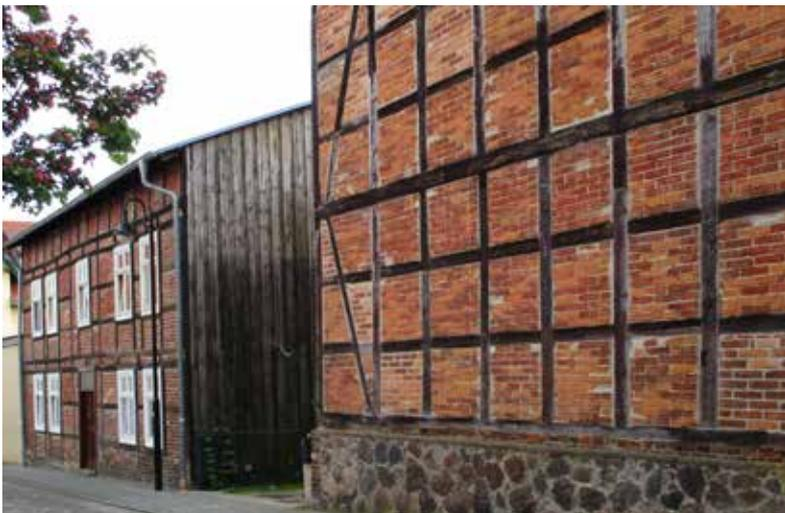
Fachwerkgebäude mit Gefachen in Sichtmauerwerk und Giebelseite in Sichtfachwerk mit geputzten Gefachen
