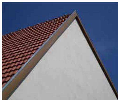
Ortgangsabschlüsse ohne Formziegel in bündiger Ausführung bzw. mit Ortgangbrett
